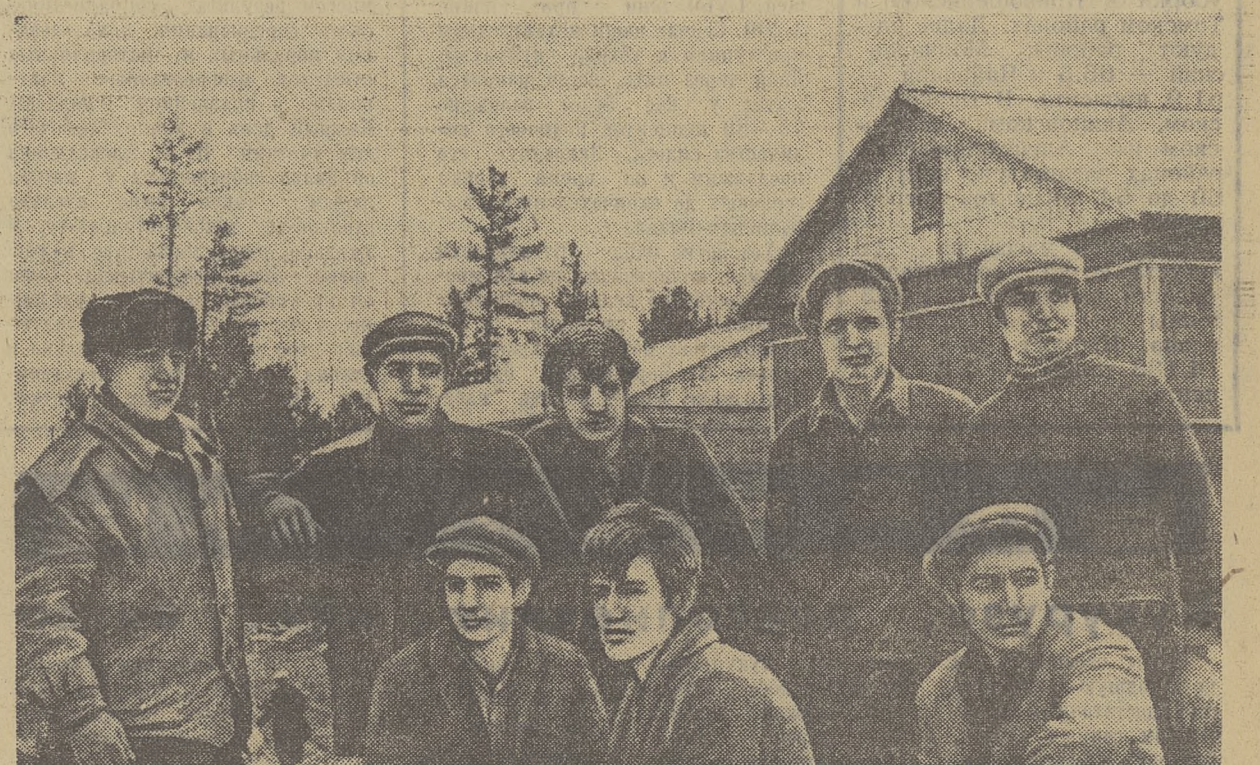
Бригада строителей, которую возглавляет С. Г. Головей (на снимке в нижнем ряду первый слева), сформирована несколько месяцев назад. Зимой все работали на строительстве сборно-замерных установок на промисле, а сейчас вновь созданы.
