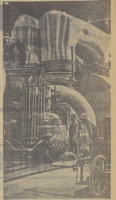
Красноярский край. На седьмом агрегате Назаровской ГРЭС ведутся пуско-наладочные работы. Здесь проводят испытания многочисленных узлов уникального теплового турбогенератора мощностью в полмиллиона киловатт.
