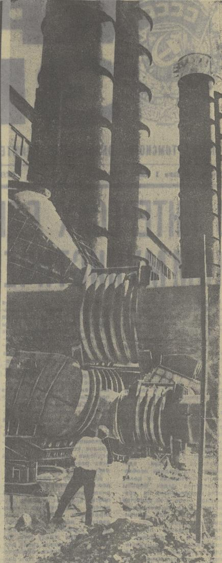
САРАТОВСКАЯ ОБЛАСТЬ. На Еланской компрессорной станции газопровода Средняя Азия — Центр завершается монтаж трех газовых турбин мощностью в 10 тысяч киловатт каждая. Их сооружает трест Союзомгазгаз. НА СНИМКЕ: на одном из участков строительства газовых турбин. Фото Е. Соколова. (Фотохроника ТАСС).
