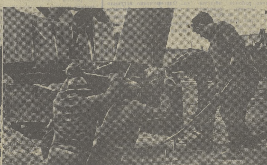
Монтаж котельной ведут студенты Верхнекетского районного отряда.
