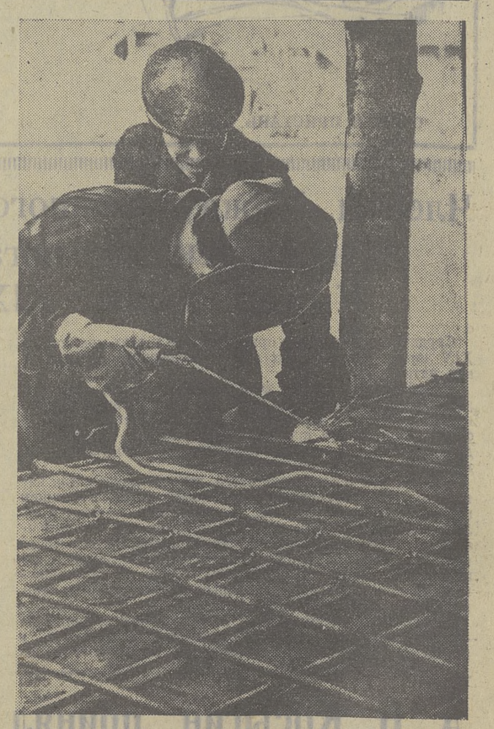
Готовится арматура для канализационно-насосной станции. Работы ведут студенты Новосибирского энерготехнического института. Фото В. Кондратьева.
