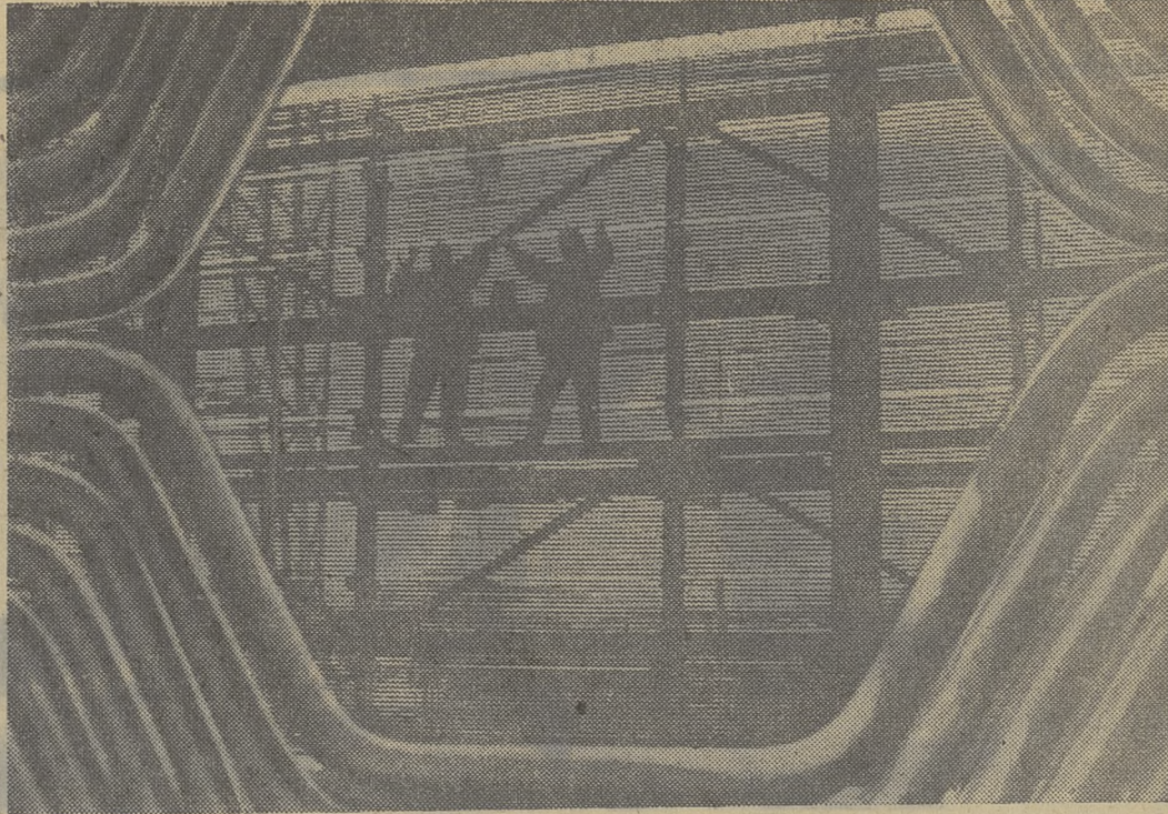
На севере Башкирии, сооружается один из важных объектов пятилетки — Кармановская ГРЭС. Она даст энергию предприятиям и стройкам Урала, нефтяным районам Башкирии. НА СНИМКЕ: идет монтаж нагревательных поверхностей котла для энергоблока Кармановской ГРЭС. Фото Б. Клиниченко.
