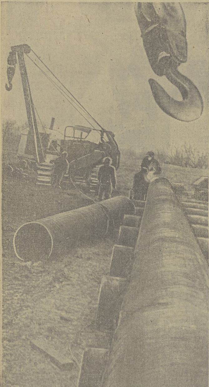
Один из участков нефтепровода Александровское — Нижневартовское. Идет сварка труб на стенде отряда подводно-технических работ.
