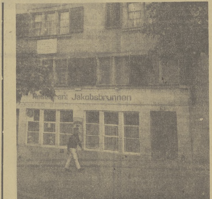
ПВЕНЦАРИЯ. Цюрих. Дом № 14 по улице Шингелгассе. Здесь с 21 февраля 1916 года по 2 апреля 1917 года жили В. И. Ленин и Н. К. Крупская. Под окном комнаты на третьем этаже, где жил В. И. Ленин, установлена мемориальная доска. Фото Г. Драгунова.
