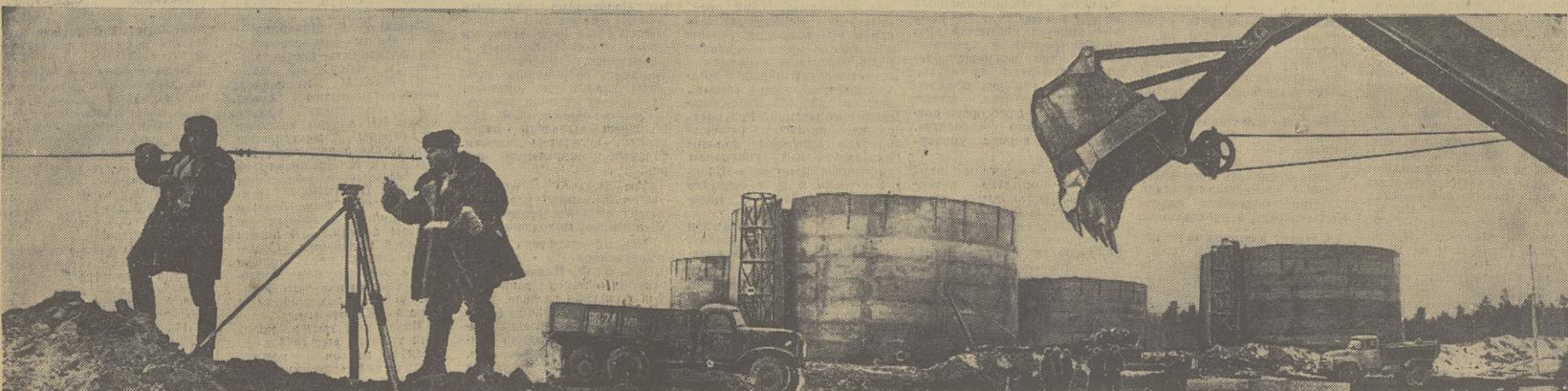
СЕЙЧАС ЗДЕСЬ ПОДНИЛИСЬ ОГРОМНЫЕ РЕЗЕРВУАРЫ ДЛЯ НЕФТИ, КОНЦЕВАЯ СЕПАРАЦИОННАЯ УСТАНОВКА, НАСОСНАЯ ОТМЕТКИ ДЛЯ КАЖДОГО ИЗ ЭТИХ ОБЪЕКТОВ ДАВАЛ ГЕОДЕЗИСТ Н. Н. МЕДВЕДЕВ.
