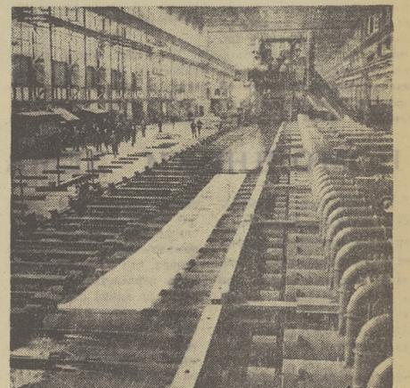
На Новолипецком металлургическом заводе дал первый прокат широкополосный прокатный стан — «2000», не имеющий себе равных в стране по производительности, скорости проката и мощности установочного оборудования. Шпиконый богатый обеспечит потребности в стальном листе многих заводов машиностроения, его продукция будет использоваться и для производства труб большого диаметра.
