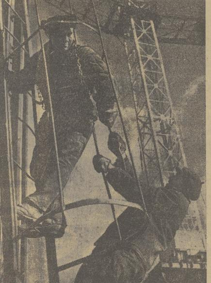
В Киеве ведется строительство нового телецентра. На 372 метра поднимается высь ажурная башня, с помощью которой будет осуществляться телевизионное вещание по трем программам на расстоянии свыше 100 километров и трехпрограммное радиовещание. НА СНИМКЕ: монтажники строительного управления № 21 треста «Центростройконструкция» И. В. Родимук (сверху) и Л. Н. Лин на монтаже конструкций телецентра. (Фотохроника ТАСС).
