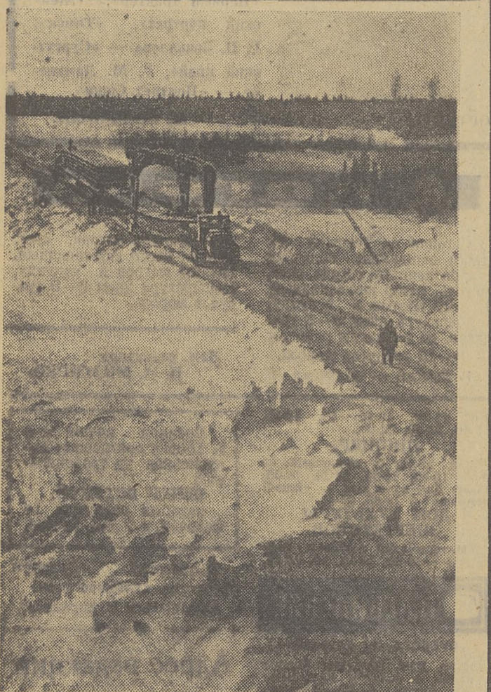
На строительстве железной дороги Тюмень—Сургут. Стальная магистраль протяженностью около 700 километров прокладывается к Среднему Приобью — новому крупнейшему нефтяному району страны. НА СНИМКЕ: таежная трасса. Идет укладка рельсов. Фото И. Сапожкова. (Фотохроника ТАСС).
