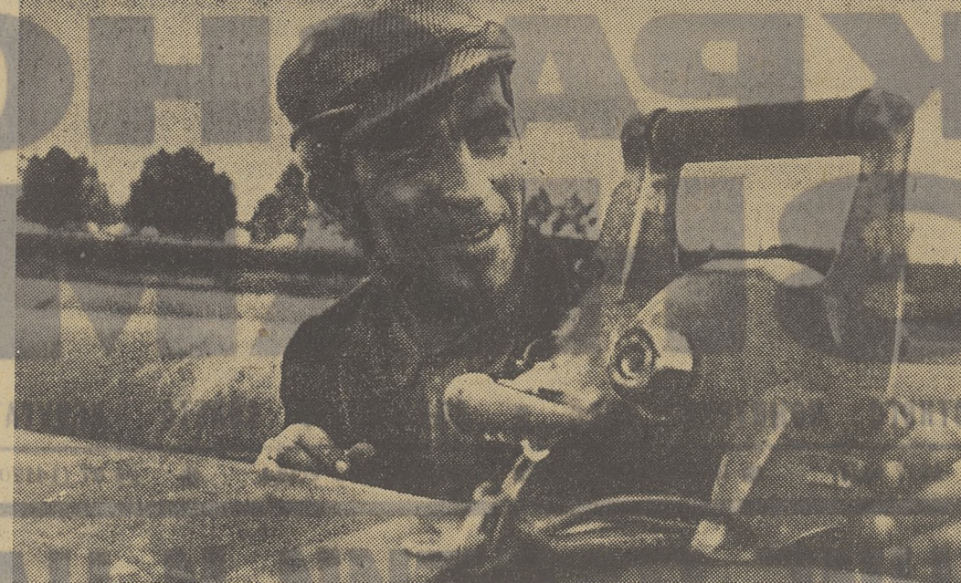
Юрий Фетисов руководит лабораторией на монтажном участке треста «Союзприродмашстрой». Каждый сварочный шов подвергается тщательной проверке специальными приборами. Первые швы нефтепровода Александровское — Анжеро-Судженск сделаны на «отлично» — говорит Юрий Фетисов. — Такими же будут и все остальные. Фото В. Ефименко.
