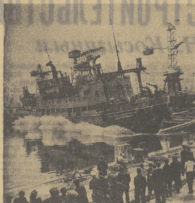
Со ступеней Бакинских судостроительных заводов имени Вано Струпа сошло новое судно «50 лет Советскому Азербайджану», предназначенное для лодочных работ на Каспии. Выходку грунта судно может осуществлять, став на якоря или опираясь на дно специальными сваями, расположенными по бортам. Выработанный грунт будет вывозиться баржами или транспортироваться по трубопроводу, который присоединяется к носовой части судна. Производительность грунтозаборной установки — 18 тысяч кубических метров смеси грунта с водой в час.
