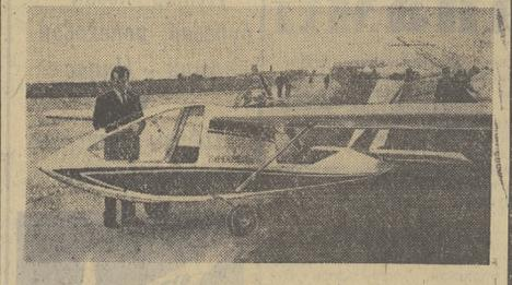
Любительный образец мини-самолета продемонстрировал недавно польский конструктор-любитель Ярослав Яновский. Этот самолет он сам спроектировал и за три года построил своими руками, установив на нем двигательной конструкции, для которого использовал два цилиндровых двигателя МЗ. Мощность двигателя — 25 л. с. при 4.000 оборотах в минуту. Столь же оригинально решена конструкция фюзеляжа и крыльев. Самолет построен из фанеры, слоистого пластика, авиационной сосны и эпоксидной смолы.
