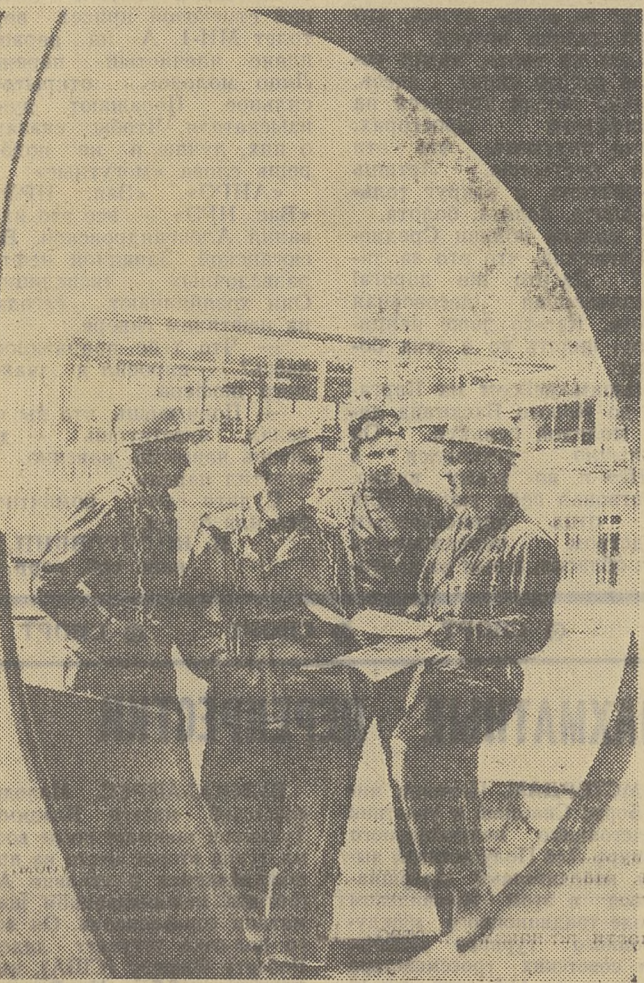
Ровно. Рабочие Ровенского специализированного № 64 с большим подъемом трудятся на сооружении второй очереди ударной стройки пятилетки. Ровенском заводе азотных удобрений. Особенно отличается здесь бригада слесарей-монтажников, которую возглавляет опытный строитель Петр Спиридонович Михалев. Ежедневно она выполняет смелые задания на 130—160 процентов с высоким качеством работ. В честь предстоящего XXIV съезда КПСС бригада решила повысить производительность труда и к 7 ноября закончить монтаж оборудования второй очереди завода. НА СНИМКЕ (справа налево): бригадир П. С. Михалев в свободную минуту беседует с членами своей бригады В. Д. Мельников, И. Н. Цыганков и А. А. Миниктоком. Фото Л. Эдвардс.
