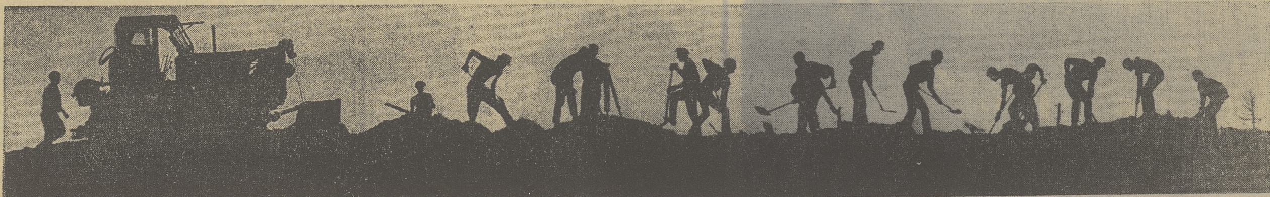
НА СТРОИТЕЛЬСТВЕ СТРЕЖЕВОГО РАБОТА СТУДЕНЧЕСКИЙ ОТ «КОМАРИК» МОС КОВСКОГО АВТОМО БИЛЬНО- ДОРОЖНО ИНСТИТУТА. НА СНИМКЕ: ОТРЯД ЗА РАБОТОЙ. Фото В. Ефименко.
