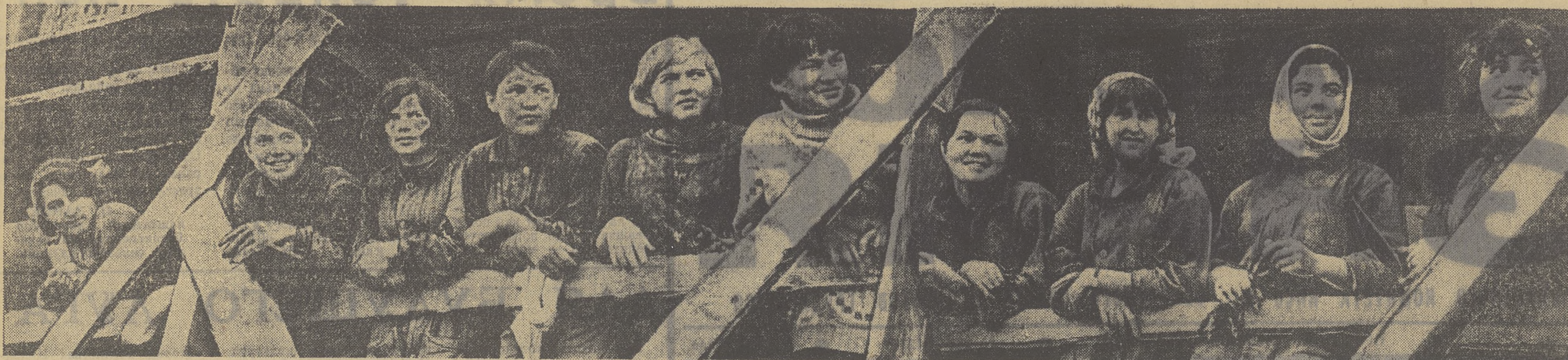
Хорошо трудятся на строительстве молодого города нефтяники Стржежского района. На снимке: Николай Боровой, Владимир Лыткин, Татьяна Подольская, Людмила Иванова из политехнического института, Татьяна Кириллова из пединститута, бригадир Марио Гольцев из строительного института, Илья Бояданов, Наталья Живодорова и Егор Гильев из университета и Аллу Ластовскую из политехнического института. Все они работают штукатурами на отделке жилых домов.
