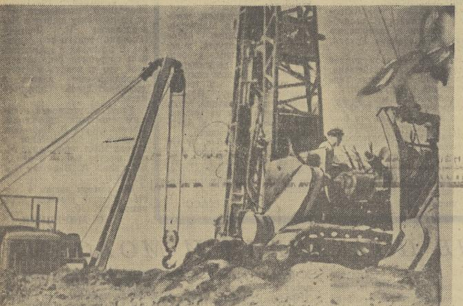
Строительная площадка Парадочка нефтеперерабатывающей станции. Здесь начато рытье котлована под основание первого из двадцати 20-тысячетонных резервуаров.
