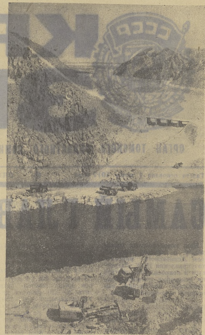
КЫРГИЗСКАЯ ССР. На реке Талас продолжается строительство Кировского водохранилища — одного из крупнейших в Средней Азии. Оно позволит оросить десятки тысяч гектаров засухливых земель. Сейчас на строительной площадке ведется обработка склонов под тело будущей плотины. НА СНИМКЕ: общий вид строительства. Фото В. Утешева. (Фотохроника ТАСС).
