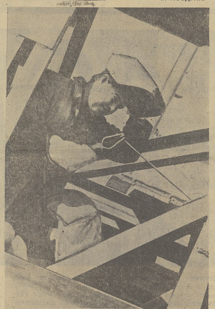
Юрий Никонов — сверщик-монтажник из бригады Владимира Сергеева. Много буровых смонтировал Юрий за время работы в Западной нефтегазодобывающей экспедиции. Монтажники, как десантники, первыми приходят в тайгу, первыми начинают дорогу к открытию.
