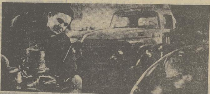
лав на завод, машина в полном смысле исчезает, растворяется на мельчайшие детали. Снимают кабину (ремонтники называют ее оперением), погружают в огромную выварочную ванну, чтобы сплавля с металла краску. Потом разбирают по винтикам мотор, ходовую часть и все, что можно разобрать. Процесс возрождения автомобиля начнется с реставрации каждой детали.
