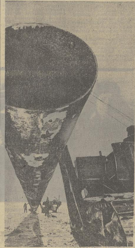
Сильные морозы открыли доступ ко всем участкам трассы нефтепровода. По этому в январе ускорились вывоза плетей труб, сварка их в трубопровод. Дренирование таежных недр производится мощными тракторами. На снимке: вывозка плетей на трассу. Снимок А. Федорова
