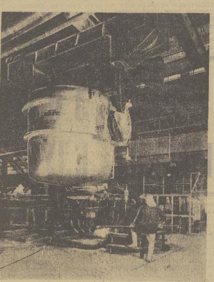
ФИНЛЯДИЯ. Внутренний вид установки непрерывной разливки стали в сталеплавильном цехе, построенном с помощью Советского Союза на металлургическом заводе в Раахе.
