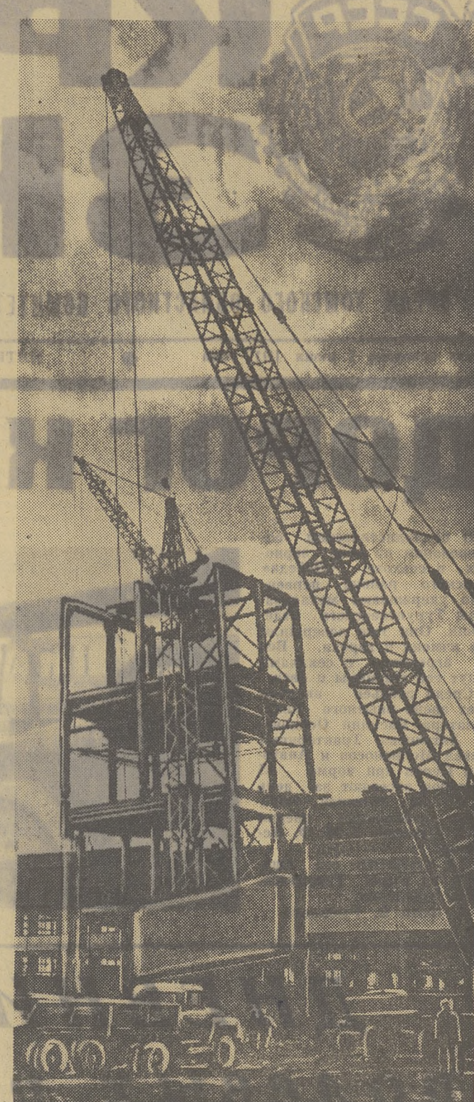
Идет монтаж мощного узла по производству бетона. Фото В. Ефименко.
