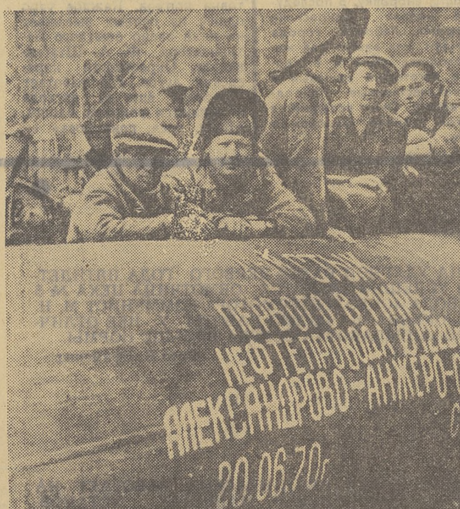
Год назад был сварен первый стык. Еще через год нефтепровод Александровское — Томск — Анжеро-Судженск будет устойчиво работать.
