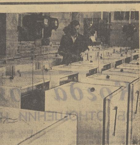
НА СНИМКЕ: холодильники «Север-6» на испытательной станции завода. Фото М. Филимонова. АИИ.
