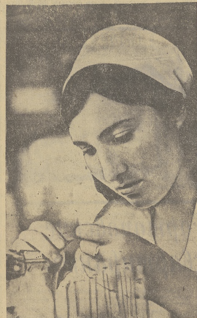
Монтаж спирали — одна из самых сложных и ответственных операций. Ольга Дубек в совершенстве овладела ею. Ольга — одна из лучших монтажниц 21-го цеха электролампового завода.
