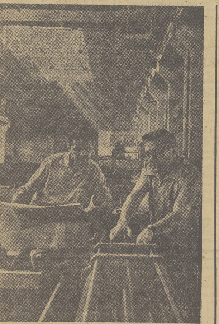
КАХАЗКАЯ ССР. Симон сделал на Азна-Аттинском заводе тяжелого машиностроения. Вы видите старшего мастера отдела технического контроля В. И. Семенова (слева). Они осматривают стан для проточки тонкостенных труб по высоколегированным сталям. Изготовленный на заводе стан предназначен для Румынии.
