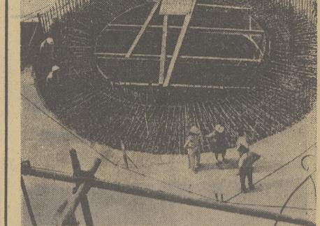
Строительство первой в Болгарии атомной электростанции в Козлодуже отмечено важным событием — началом возведения бетонных стен первого реакторного отделения, где разместится один из реакторов станции мощностью 440 тысяч киловатт. Всего в Козлодуже будет установлено два таких реактора.
