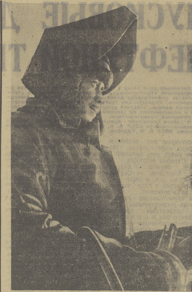
Несмотря на молодость, сварщик строительного управления № 1 треста «Нефтепроводстрой» Марс Каримов уже участвовал в сооружении газопровода Оренбург — Занск, нефтепровода Усть-Балык — Омск. Сейчас он строит нефтепровод Александровское — Анжеро-Судженск. Ежедневную норму выполняет в полтора-два раза.
