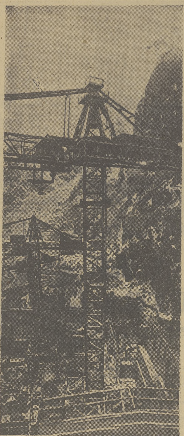
НА СНИМКЕ: на строительстве Токтогульской ГЭС.
