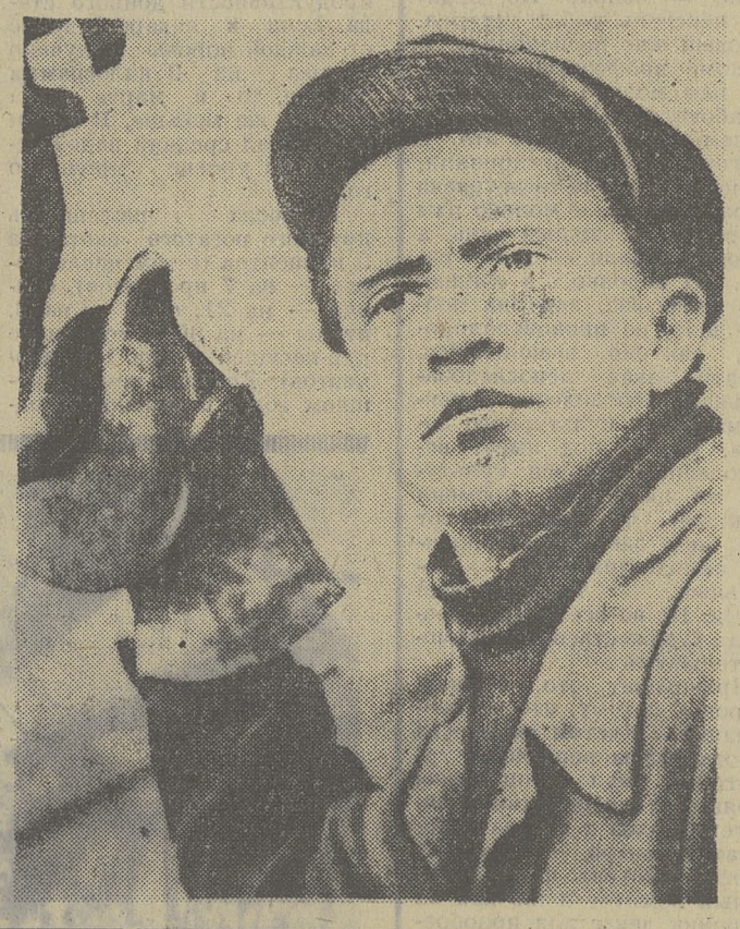
НА СНИМКАХ: бригадир монтажников П. И. Вшивков; краны ждут навигацию. Фото автора.
