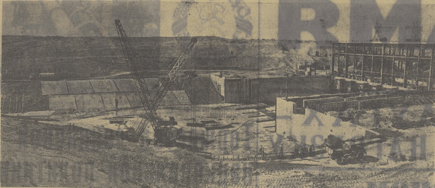
Крам безмолвия называли некогда Каршинскую степь. Теперь она оглашается деловитым рокотом мотоботов. Здесь сооружается канал протяженностью 200 километров, на берегах которой протянется новая хлопковая долина. Воду из Амударьи подведут на обширные плантации шесть насосных станций.
