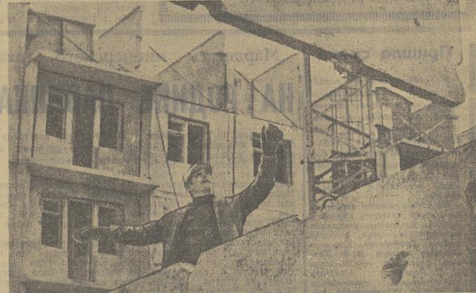
Учитель обладает отличными теплоизоляционными свойствами, отстойностью, кроме того, он долговечен. Низкая стоимость материала, простота возведения, высокая производительность труда — вот что отличало строительство этого здания.
