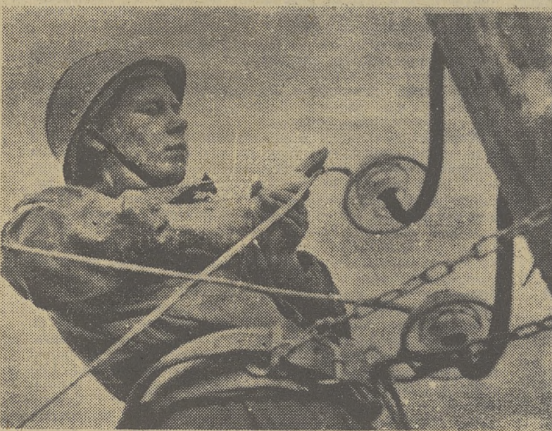
Богачево. Густой стеной стоят березы, гордо взметнулись надкра. Здесь размашисто работает полигонное хозяйство управления «Томскэнерго». Строгие ряды опор с нитками проводов на сверхвысоких изоляторах. Трансформаторные подстанции, распределительные щиты, разветвители, стеной, имитирующая дом. И — развешенная на флагштоке флага.
