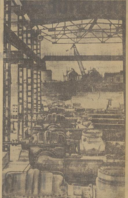
Агрегаты строящейся Парабельской нефтеперерабатывающей станции будут создавать в трубах давление, способное гнать нефть с большой скоростью. Фото Э. Стойлова.
