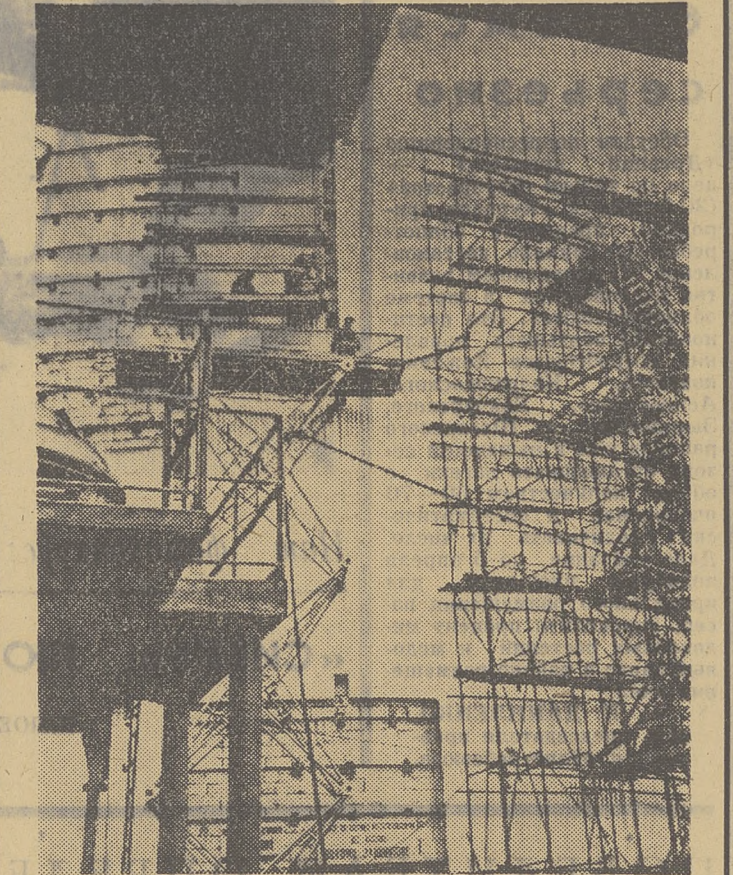
ПНР. В институте атомных исследований в местечке Сьерпе под Варшавой строится атомный реактор «Мария» (на снимке), названный так в память об известном польском ученом М. Складовской-Кюри. В его сооружении принимают участие советские ученые и инженеры. (Фото ЦАФ — ТАСС).
