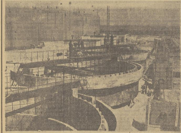
Сорок две тысячи кубических метров балластных вод будут ежедневно очищаться на станции, строительство которой скоро закончится в Одесском морском порту. Балластная называется вода, которая закачивается в танки возвращающегося из рейса наливного судна после того, как они освободятся от груза нефти. Перед заходом в порт за новым грузом балластную воду прежде обрабатывали в море, что вело к
