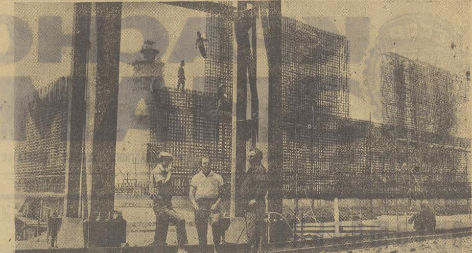
Армянская атомная электростанция мощностью 800.000 киловатт — одна из крупнейших строек республики. Здесь одновременно возводятся десятки объектов. Важнейший из них — главный производственный корпус. НА СНИМКЕ: идет монтаж фермопакетов вокруг шахты реактора. Фото В. Непрута и А. Агаджаняна. (Фотокроника ТАСС).
