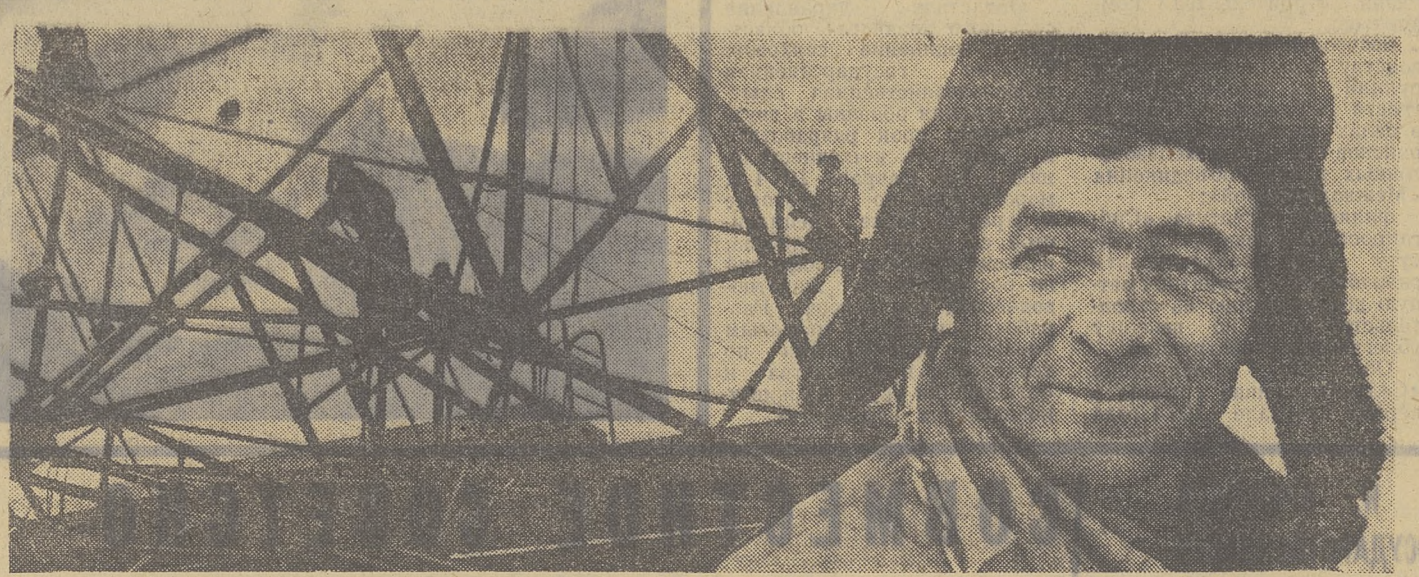
Двадцать лет работает монтажником В. М. Коноп. Он принимал участие в строительстве многих важнейших объектов Томска и области. Опытный монтажник СМУ-7 управления «Химстрой» выполняет смесные задания на 160—170 процентов.
