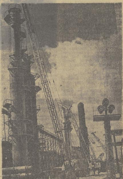
С каждым днем все четче вырисовываются контуры строящегося в Белоруссии Мозырского нефтеперерабатывающего завода. Завершается возведение 150-метровой дымовой трубы, растут колонны главной технологической установки, монтируются холодильная установка, прокладываются трубопроводы на объектах сооружений. В будущем году вступит в строй первая очередь завода.
