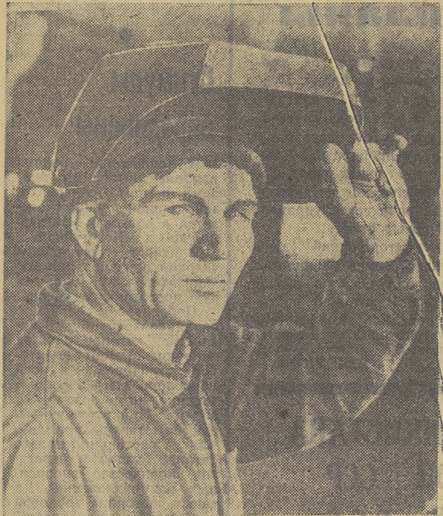
И. П. Макинов работает в формовочном цехе завода ЖБК-100. Иосиф Прокопьевич — опытный сварщик, и ему поручают самую сложную работу по ремонту дежового оборудования и форм для железобетонных плит перекрытия.
