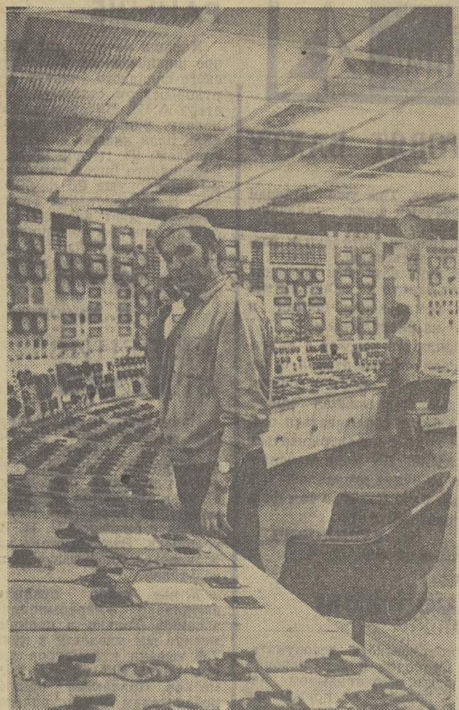
ДНЕПРОПЕТРОВСКАЯ ОБЛАСТЬ. Закончилось сооружение Криворожской ГРЭС-2, введен в строй действующих последний, 10-й энергоблок. Эта тепловая электростанция одна из самых крупных в нашей стране. Проектная мощность Криворожской ГРЭС-2 — 3 миллиона киловатт. НА СНИМКЕ: передовой машинист энергоблока № 8 Владимир Нечай. Фото А. Запары. (Фотохроника ТАСС).
