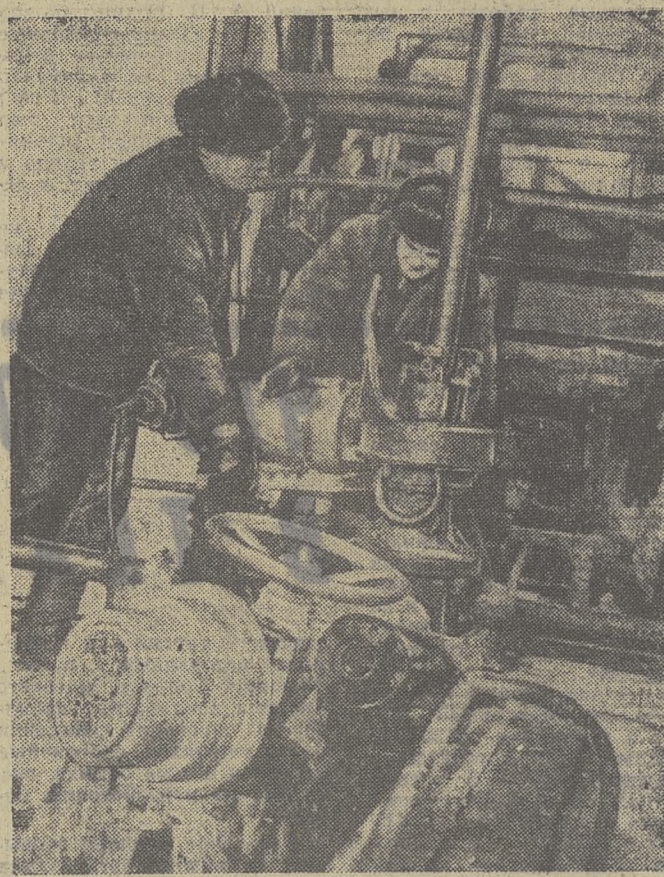
Мастер переловой бригады Владимир Ордин (слева) и рабочие А. Матаев и А. Крючков ведут ремонт скважины.
