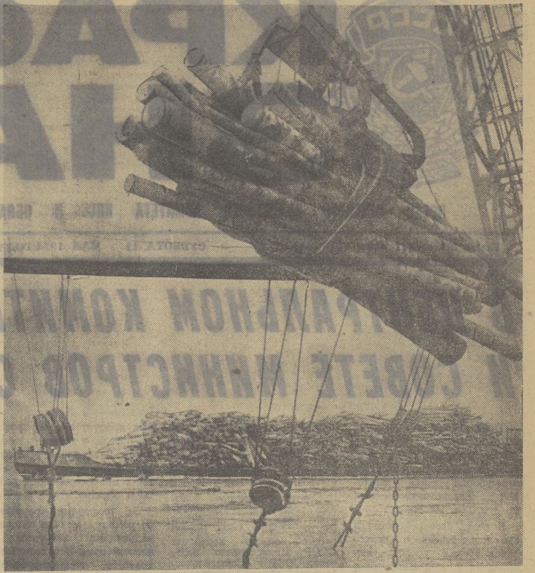
Уже несколько лет томичи прогрессивной технологией выгружают древесину по «баржа-берег». Минувшая весна, лес попадает прямо на эстакаду. Фото Э. Стойлова.
