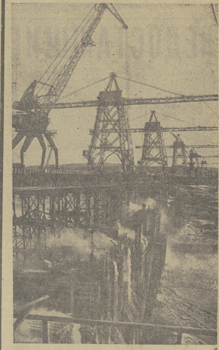
ПУЛЬС УСТЬ-ИЛИМА Первые три агрегата Усть-Илимской ГЭС строители и монтажники обвязали вехами в действии в конце нынешнего года. Напряженно трудятся бригады на сооружении здания гидроузла и
