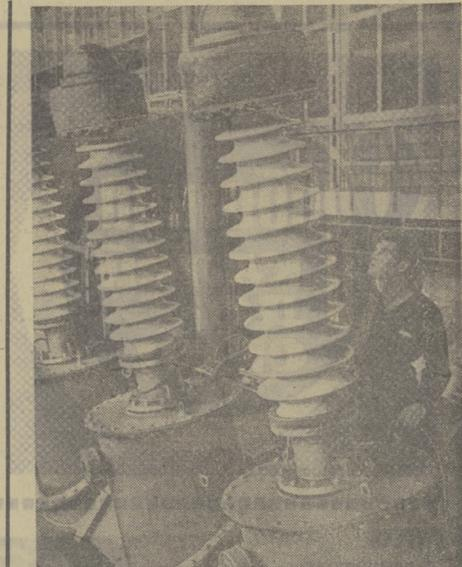
На головном предприятии производственного объединения «Запорожтрансформатор» из строящейся Днепротэ-2 изготовлен первый трехфазный трансформатор с циркуляционным охлаждением мощностью 250.000 киловольтампер и рабочим напряжением 150 киловольт. НА СНИМКЕ: слесарь-электромонтажник Николай Пономаренко подготавливает трансформатор к испытаниям. Фото А. Красовского. (Фотохроника ТАСС).
