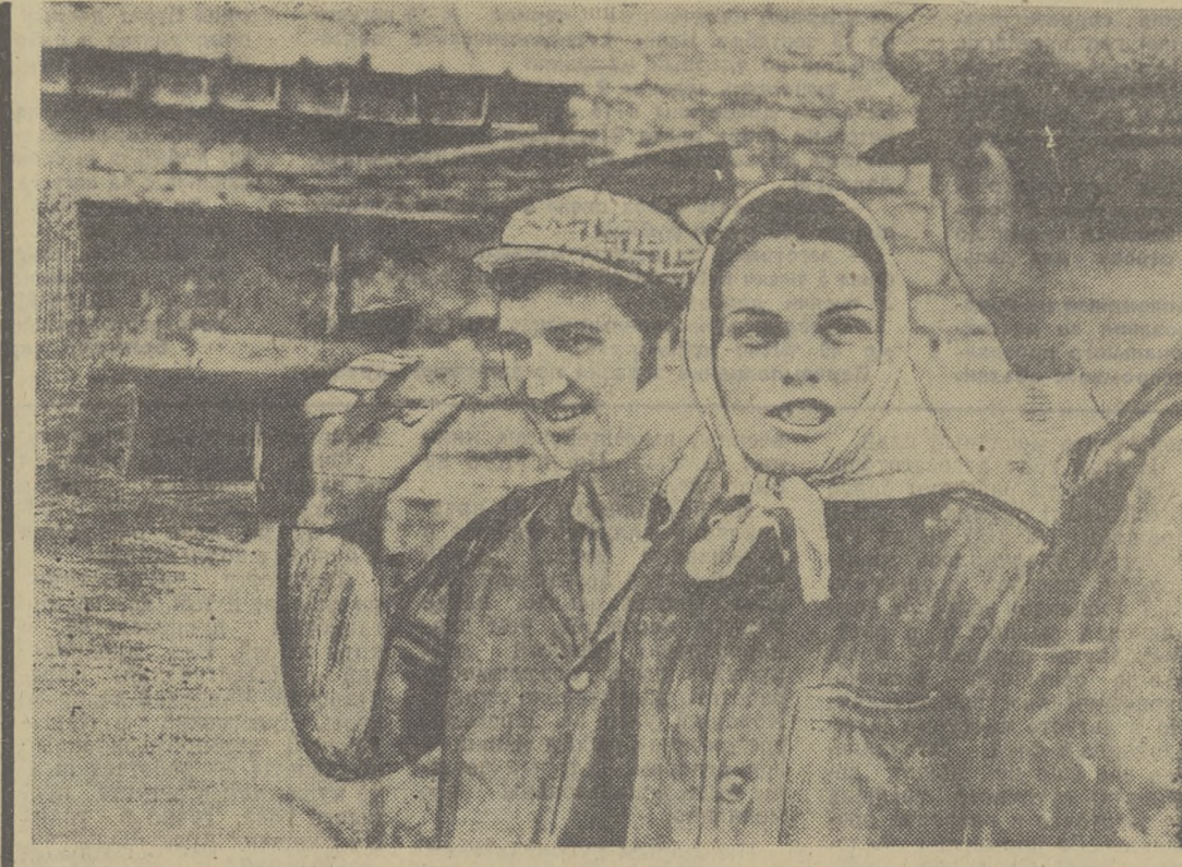
Штукатуры комсомольско-молодежной бригады Александра Кынина из ПМК-14 объединения «Совхозкоммундораз» полугодную программу выполнили на 175 процентов. Качество их работы только отличное. Сейчас бригада трудится на строительстве 75-квартирного жилого дома.
