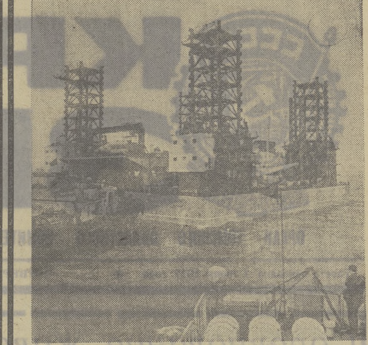
Завершив переход от устья Волги, в станицу Азербайджана прибыла новая плавучая буровая установка «Бакы» (на снимке). Этот передвижной стальной островок, предназначенный для бурения шестидесятиметровых разведочных скважин на участках моря глубиной до 60 метров, построен корабельными астраханского завода «Красные баррикады».
