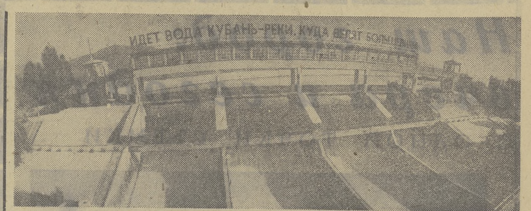
СТАВРОПОЛЬСКИЙ КРАЙ. Закончилось строительство второй очереди большого Ставропольского канала, директивной стройки пятилетки. Первая очередь канала имеет протяженность 159 км, у станции Усть-Дзугутинской 30-метровая плотина остановила стремительный бег Кубани. Река пошла по новому руслу. Строители успешно справились с поставленной задачей. Они сдали участок в эксплуатацию на 14 месяцев раньше намеченного срока. Фото К. Тарусова. (Фотохроника ТАСС).
